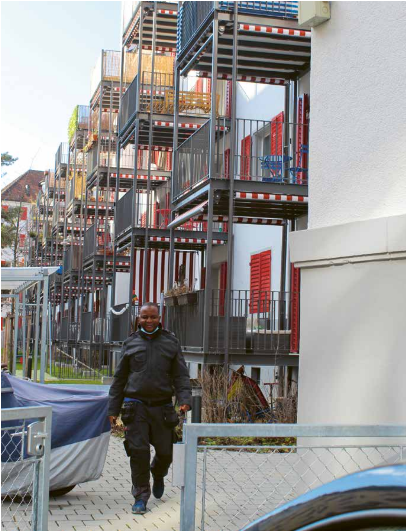
Neue Aussenanlage und Balkone Hof Stierliweg, Siedlung Denzlerstrasse (Foto: Tina Siebert).
